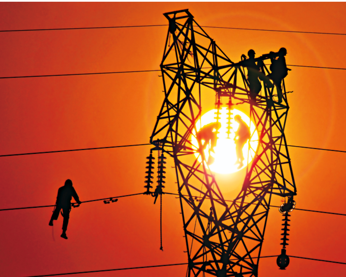
輸電線路維護現場
