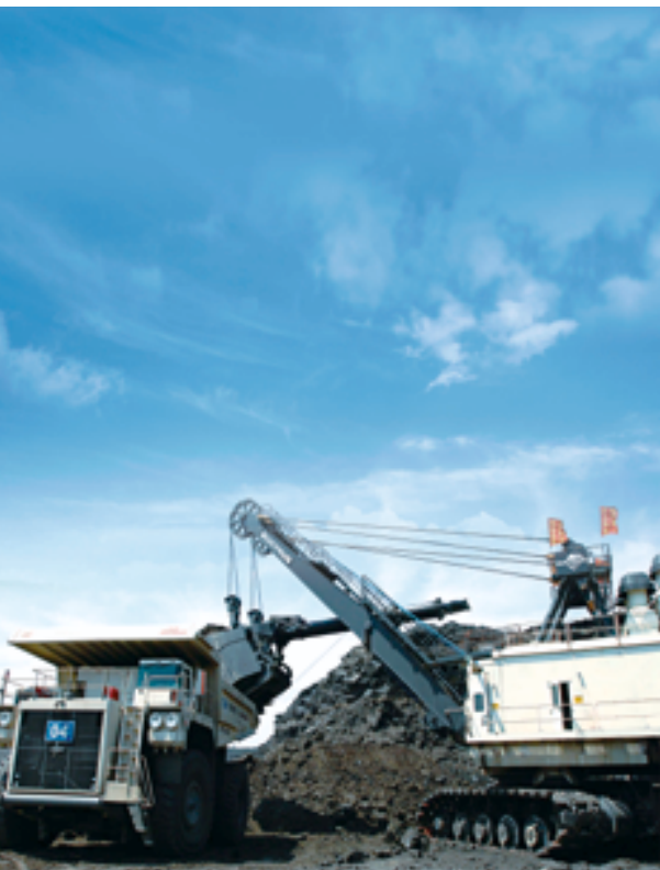
露天矿剥离工作现场
