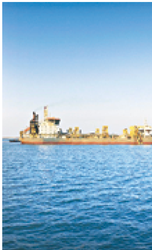
神华天津煤码头现场
